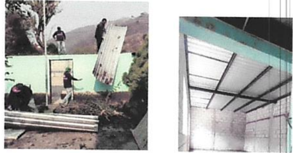
Foto 2: desmontando estructura y lámina para cambio
