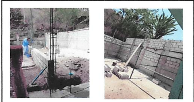
Foto 3: Ampliación de salón a 8m por 5m, hacia el frente y altura
