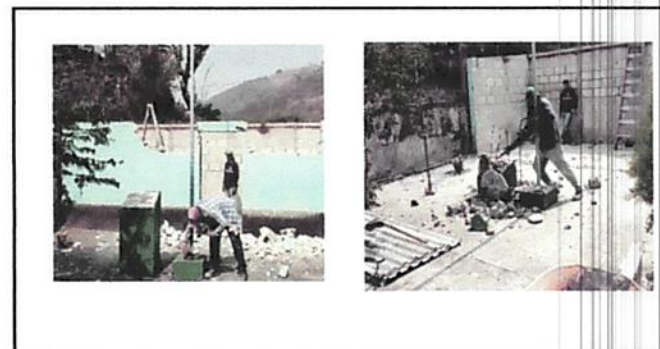
Foto 6: Demolición de asta de bandera y plaqueta para traslado estratégico.
