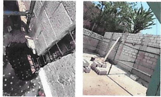
Foto 4: Reforzamiento de columnas en pared.
