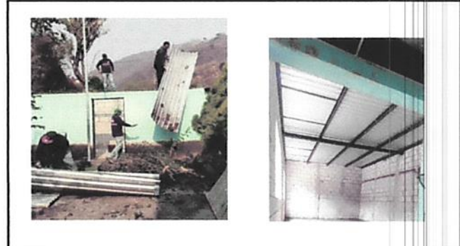
Foto 2: desmontando estructura y lámina para cambio
