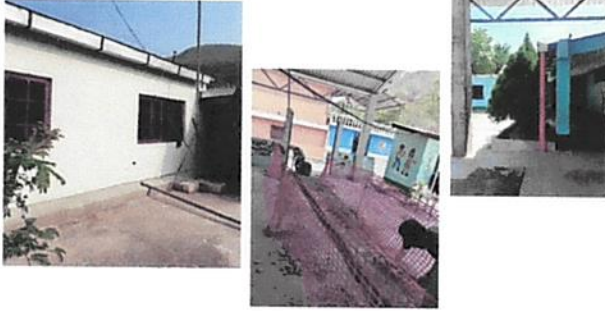
Foto 1: canales y sanjas para caídas de aguas pluviales.
