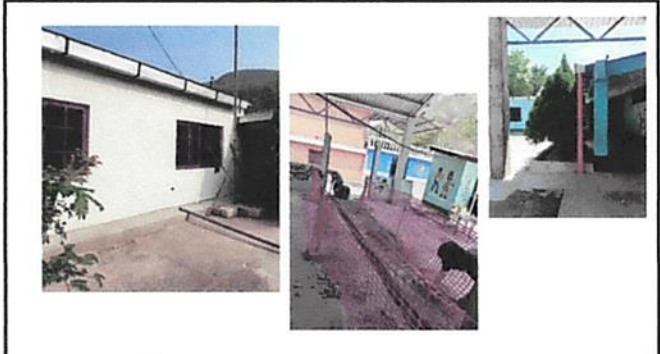
Foto1: canales y sanjas para caídas de aguas pluviales.
