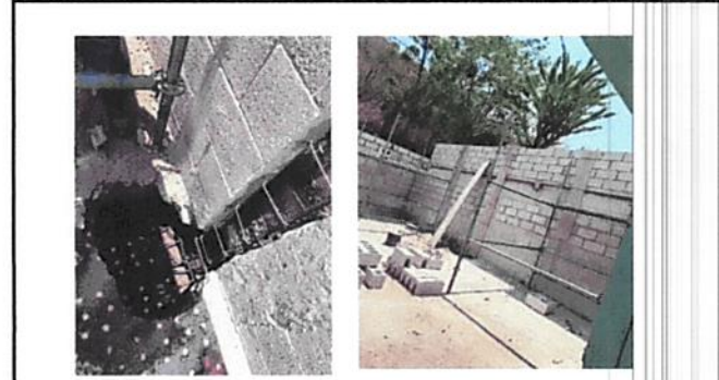
Foto 4: Reforzamiento de columnas en pared.
